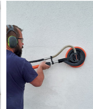
Putz abfräsen mit PKD Scheibe
