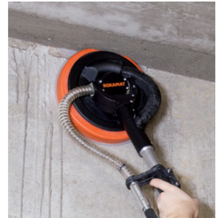
Betongrate entfernen
