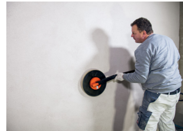
Variabel einstellbare Drehzahl ermöglicht eine perfekte Filzstruktur
