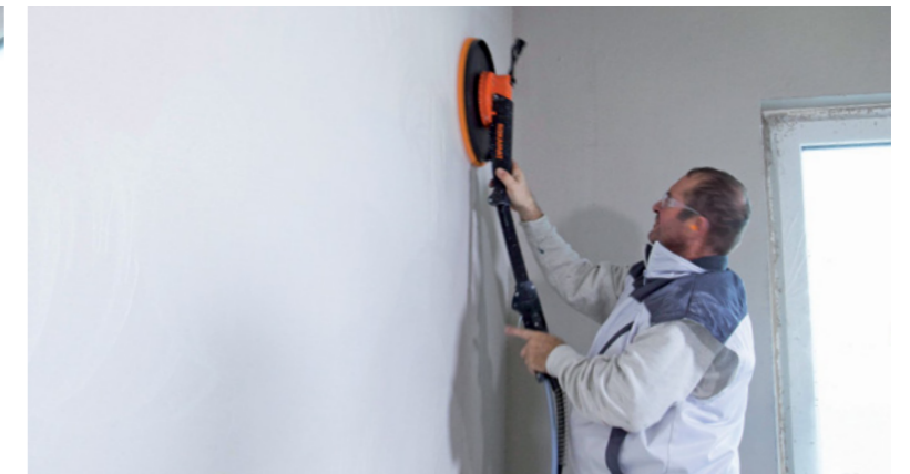
Arbeiten mit niedriger Drehzahl möglich, zur optimalen Abstimmung mit dem Putz
