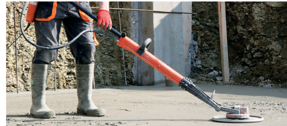
Egalisieren von Betonflächen
