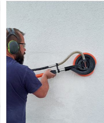
Putz abfräsen mit PKD Scheibe
