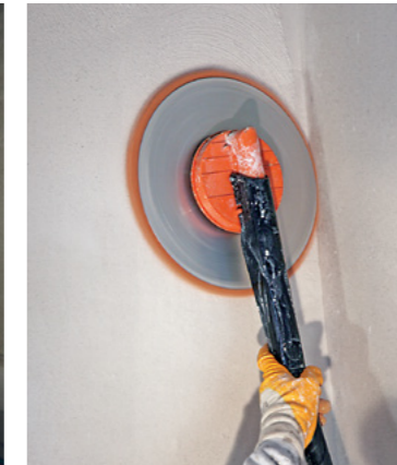
Filzen bis an die Kanten
