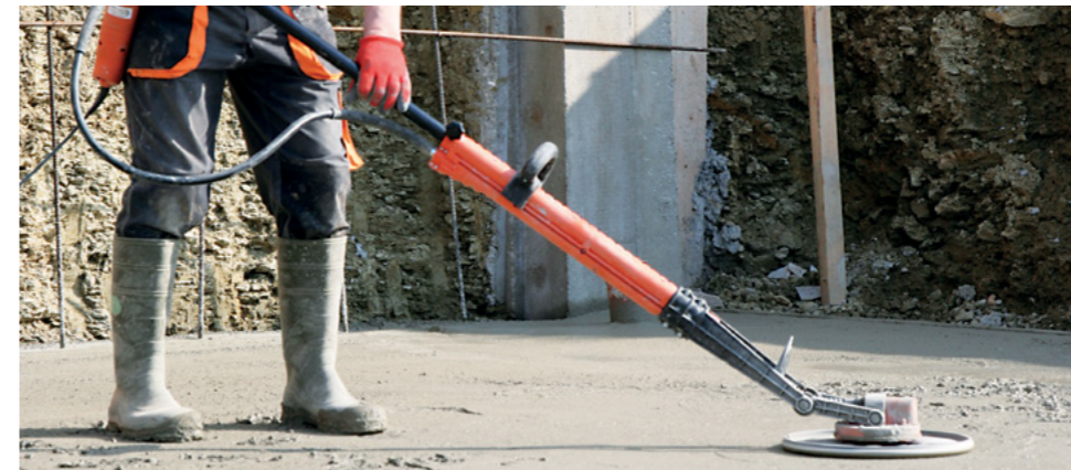
Egalisieren von Betonflächen
