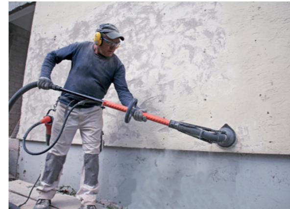
Alte Farbe und Putz entfernen
