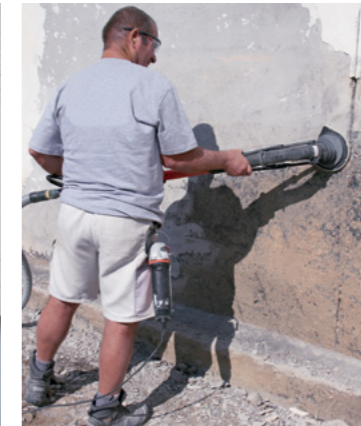
Bitumen schleifen mit dem PKD-Schleifteller
