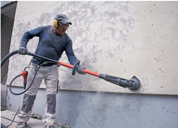
Alte Farbe und Putz entfernen
