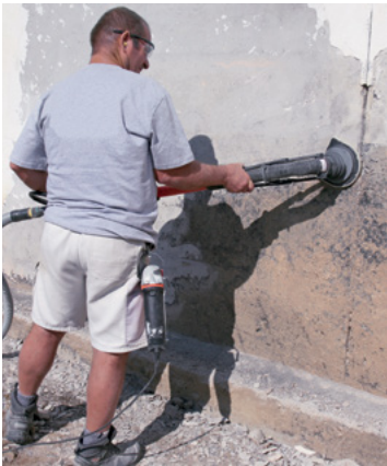
Bitumen schleifen mit dem PKD-Schleifteller
