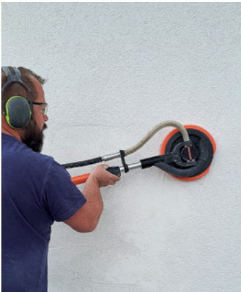
Putz abfräsen mit PKD Scheibe
