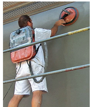
Bequemes Arbeiten auf dem Gerüst
