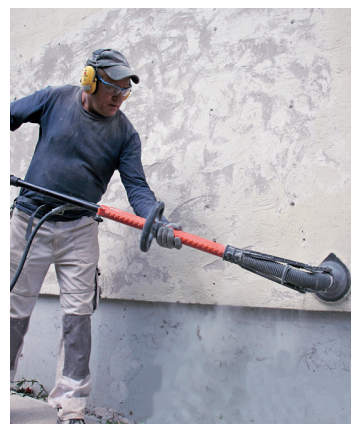
Alte Farbe und Putz entfernen
