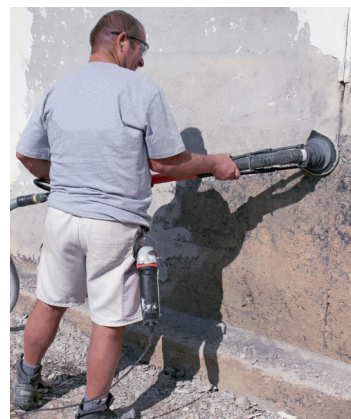
Bitumen schleifen mit dem PKD-Schleifteller
