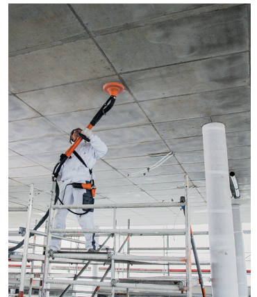
Sichtbeton schleifen
